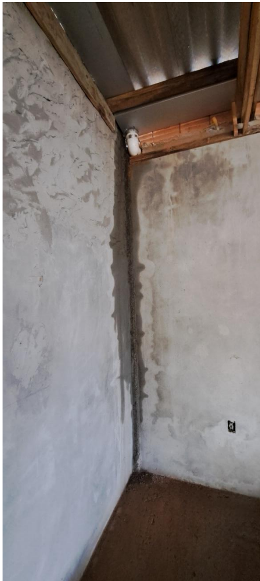
Figura 13 – Estrutura do telhado/calhas danificadas e mal executadas
