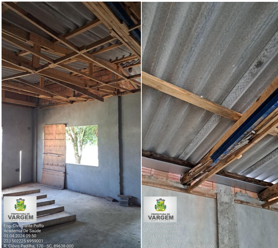
Figura 11 – Estrutura do telhado danificado e mal executado
