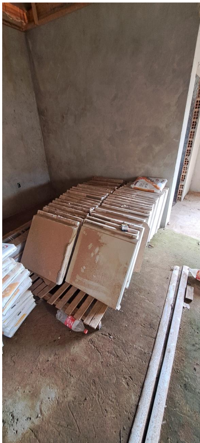
Figura 23 – Insumos da obra armazenados de forma incorreta
