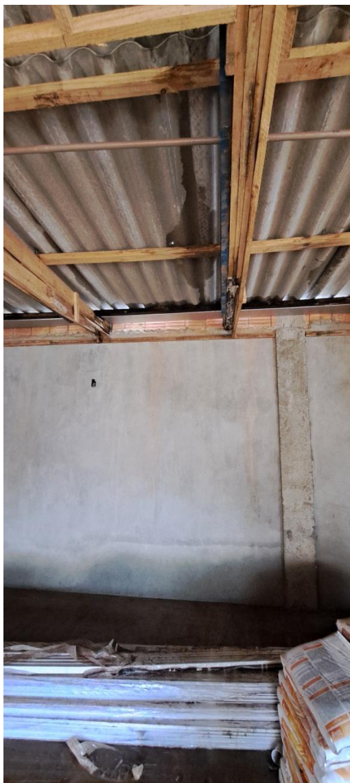
Figura 14 – Estrutura do telhado/calhas danificadas e mal executadas
