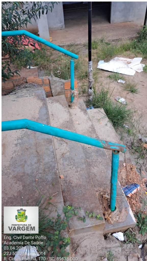
Figura 08 – Guarda-corpos danificados
