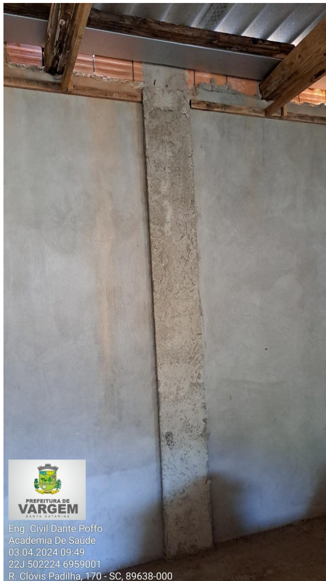
Figura 18 – Área de emboço interno a ser refeito
