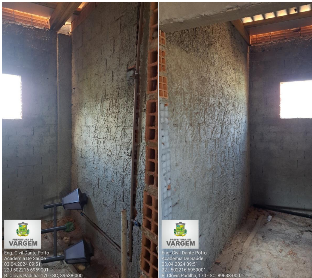
Figura 20 – Paredes do banheiro masculino no chapisco
