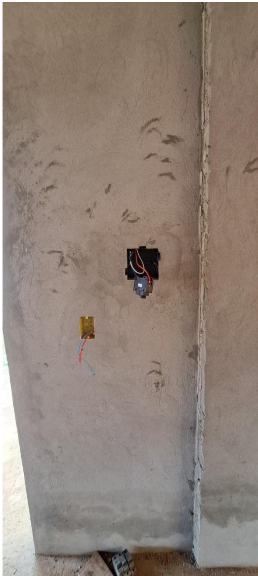
Figura 25 – Caixa de quadro elétrico com tamanho incompatível
