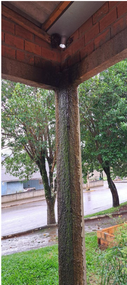
Figura 15 – Estrutura do telhado/calhas danificadas e mal executadas
