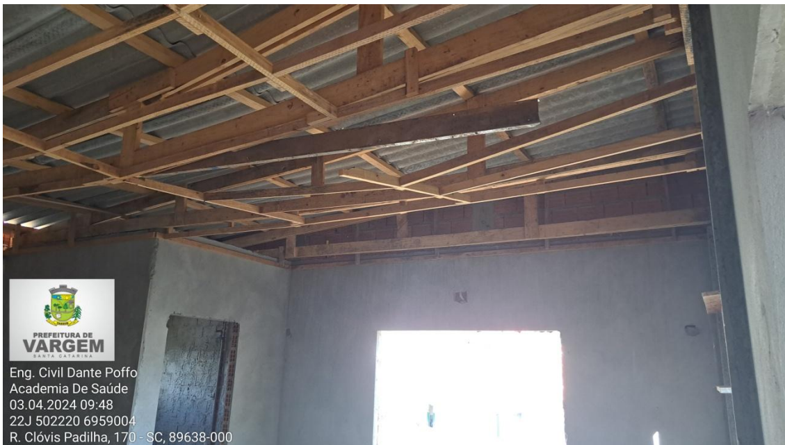
Figura 10 - Estrutura do telhado mal executado e danificado
