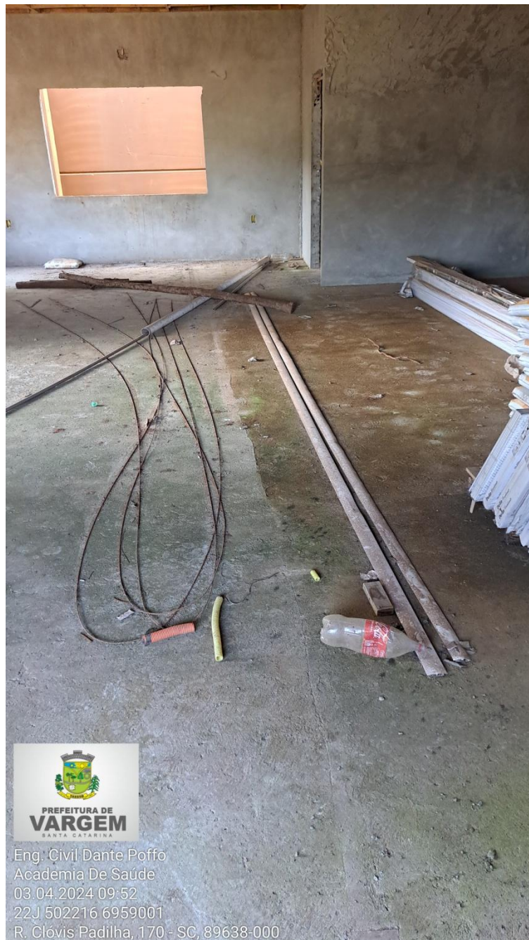
Figura 22 – Contrapiso com presença de impurezas a ser limpo
