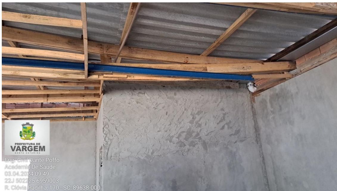
Figura 16 – Área de emboço interno a ser refeito
