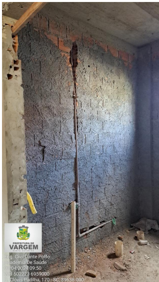
Figura 19 – Paredes da banheiro feminino no chapisco
