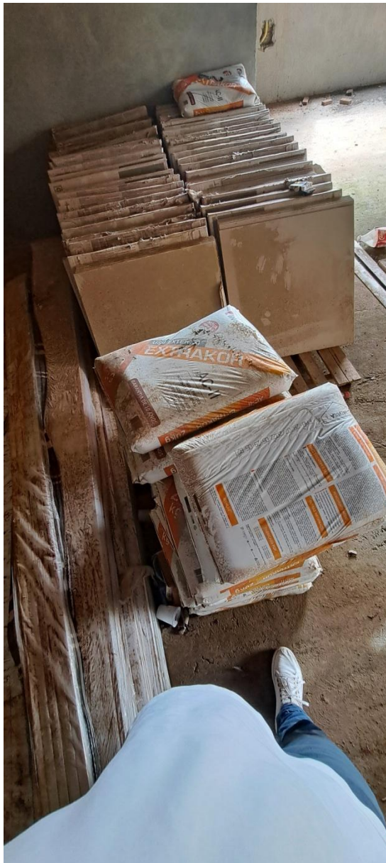
Figura 24 – Insumos da obra armazenados de forma incorreta
