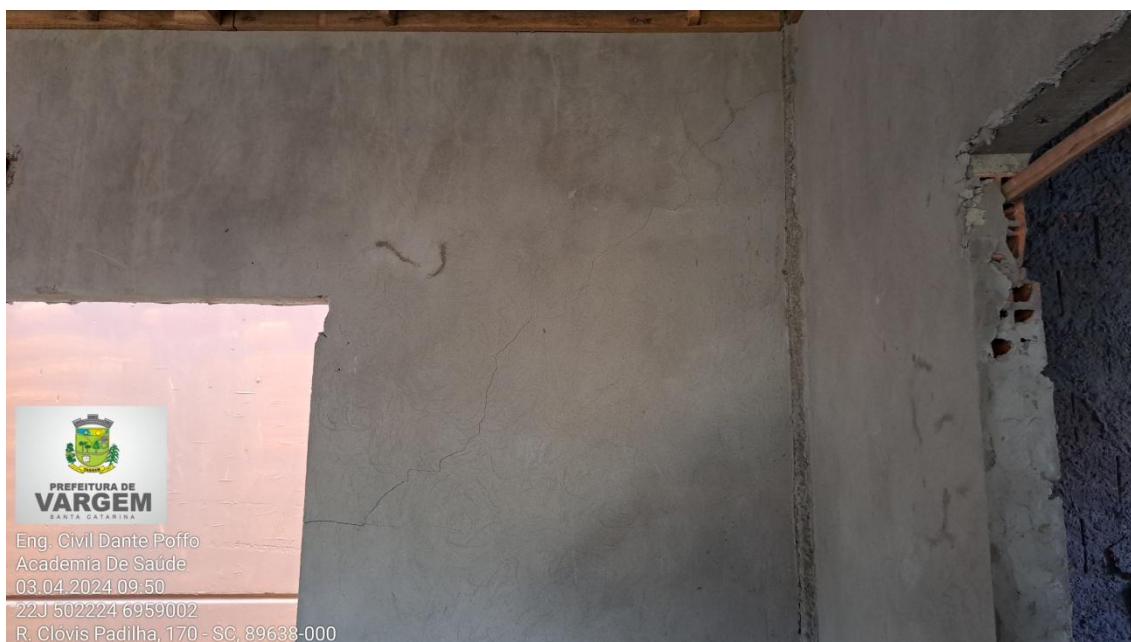
Figura 17 – Área de emboço interno a ser refeito
